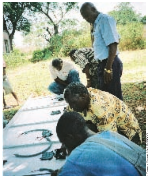
Au cours d'ateliers de formation sur le terrain organisés par l'UNESCO en 2003 à Bamako au Mali, câblage électrique de panneaux solaires et installation de systèmes photovoltaïques par les participants durant les travaux pratiques
