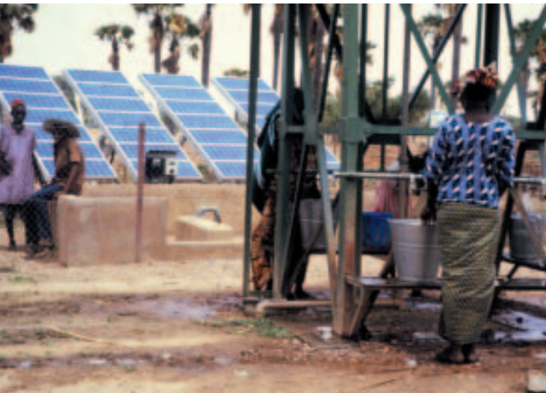
Des femmes remplissent des seaux à l'aide d'une station de pompage solaire, ce leur évite de parcourir plusieurs kilomètres
