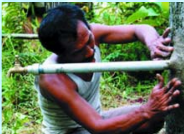
Un villageois pose un robinet sur le paroi d'une citerne d'eau
